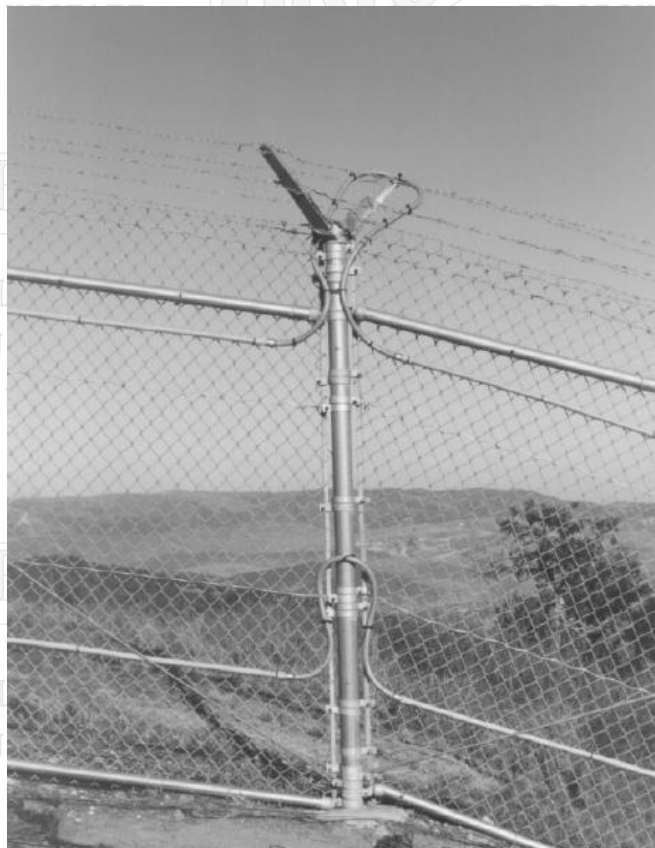
Fig. 22 Gard protejat cu fibra optica.
