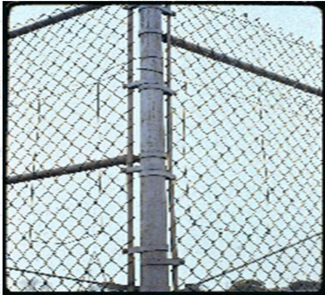
Fig. 21. Amplasarea in forma de S (serpuita) pentru cresterea sensibilitatii de detectie.
